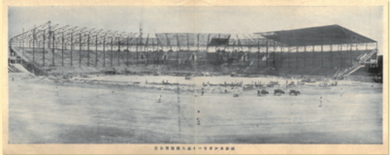
図2「鉄筋コンクリート造大観覧席全景」
